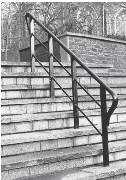
1997 – Trapleuning aan de trappen van de St.-Corneliusparking te Aalter.
