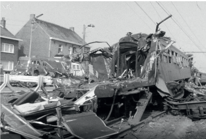
Het opengereten wrak van de stoptrein ter hoogte van de Loskaaistraat.
