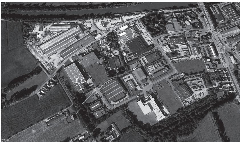
Industriepark Aalter: Zone Langevoorde. Afbeelding Google Earth
