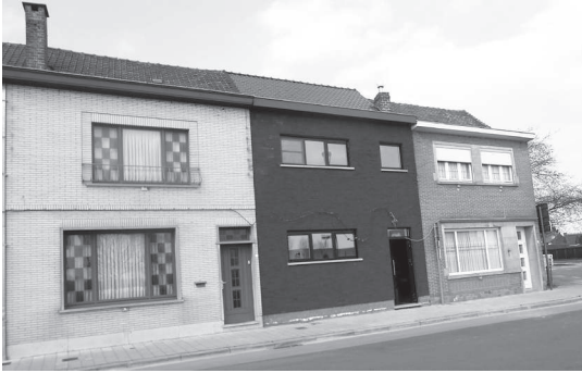
De middelste woning met donkere gevel is de verbouwde, ouderlijke woning van Julia. In 1928 was dat Oostmolenstraat 10.
