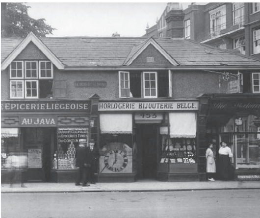
Handelszaken in de omgeving van het Belgische munitiefabriek in Richmond (Engeland).
