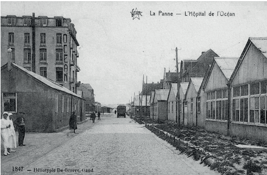
Het hotel l'Océan in Depanne dat omgebouwd is tot hospitaal voor de verzorging van gewonden.
