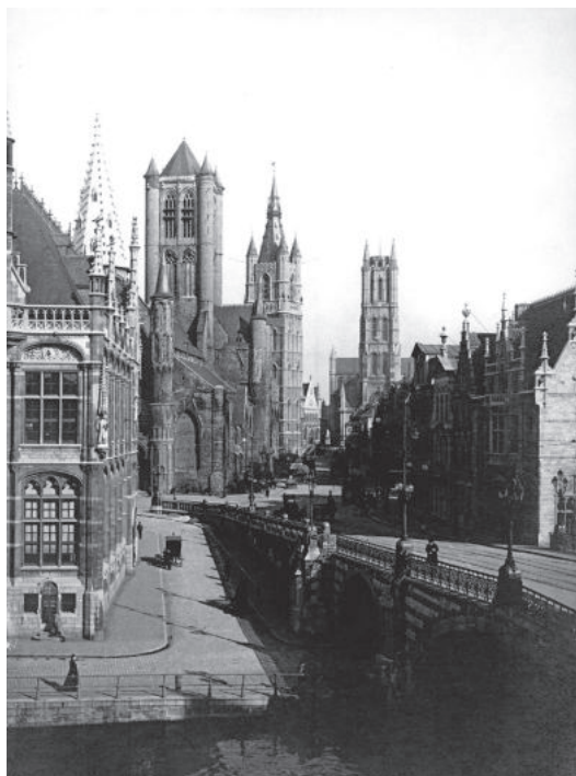
Uitzicht na de bouw van het Postgebouw en de renovatie.
