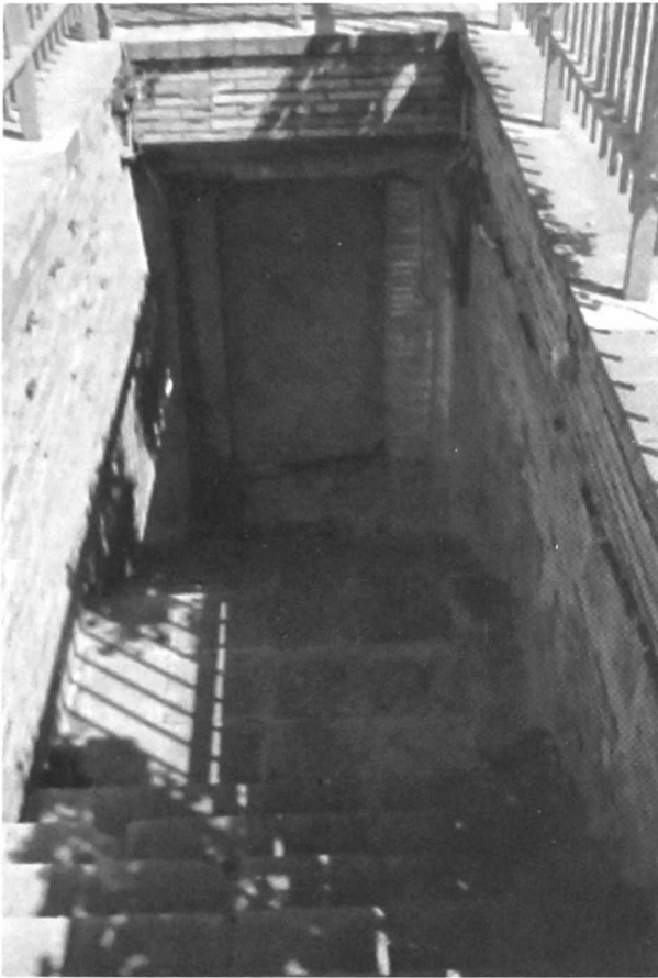
Toegang tot de schuilkelder op De Plaats in Knesselare.
