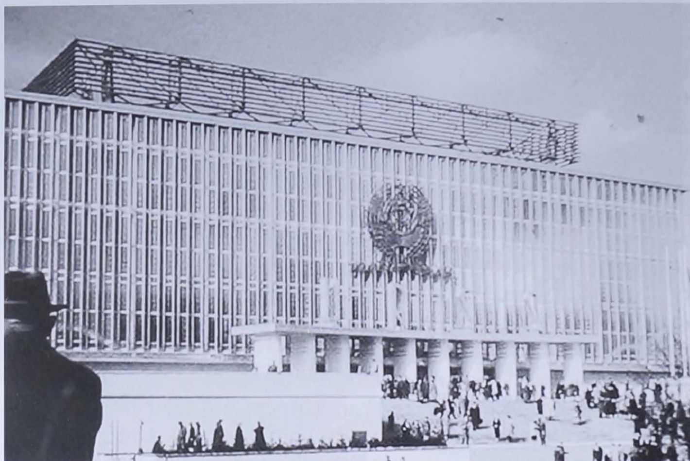
Het Russisch paviljoen, een rechthoekige blok van staal en glas.
