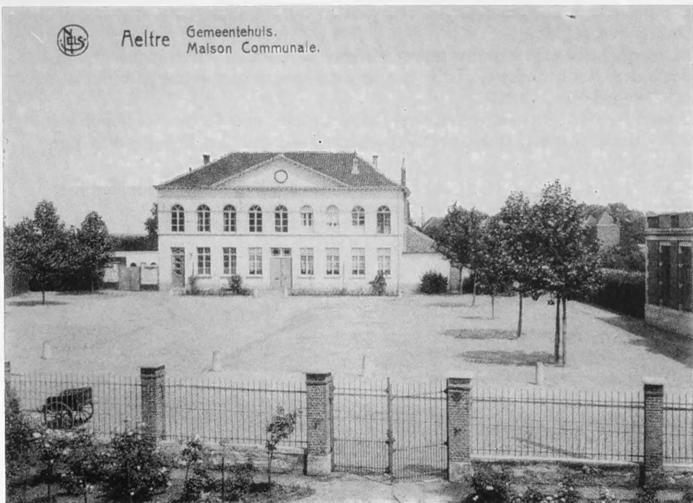
Gemeentehuis van Aalter. Links de schoolpoort en op de voorgrond de stootkar, een verdwenen vervoermiddel.
