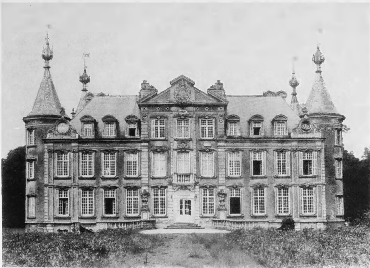
Het sierlijk motief op het fronton en de bovenste dakvensters zijn nu verdwenen.
