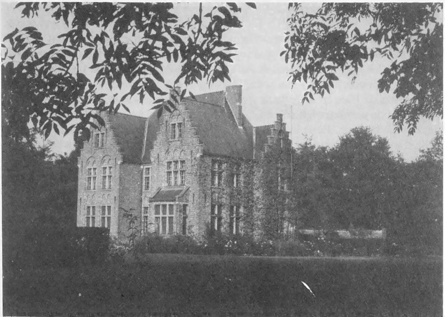
Het huidige kasteel van Schuurlo
