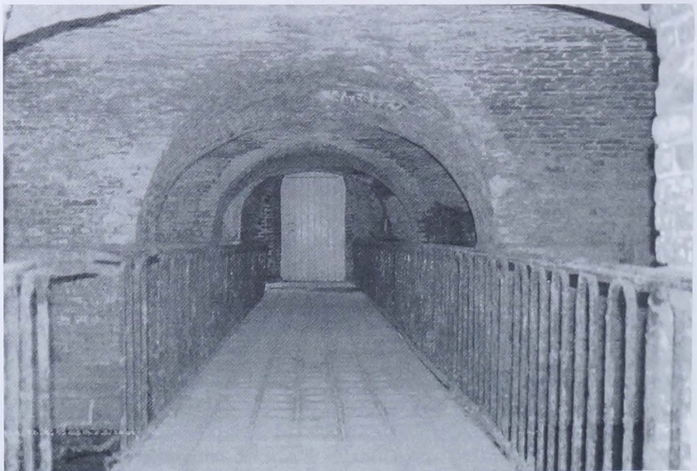
Diensttoegang onder de brug die toegang geeft tot het kasteel.
