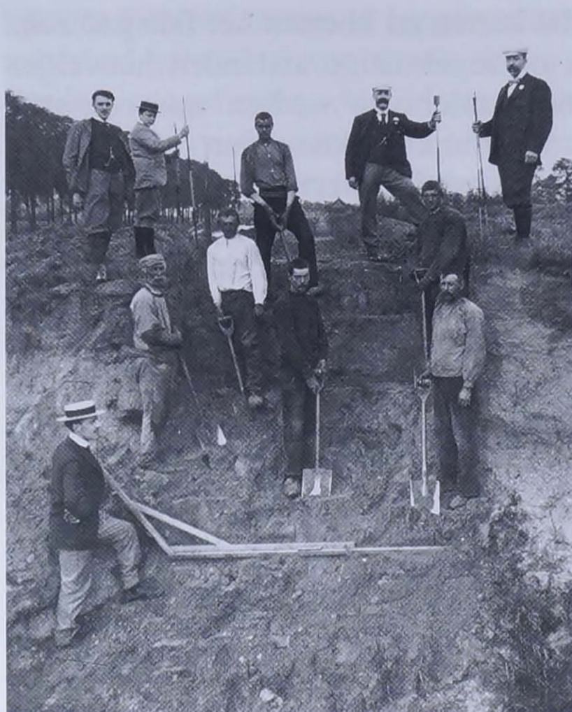
Aanleg van fietspad in de omgeving van Nobelstede. Links op de voorgrond staat Carlos Dewulf.
