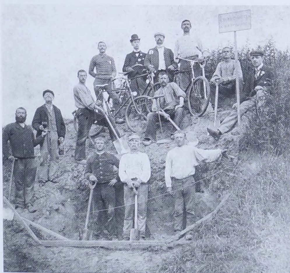
Aanleg van fietspad in de omgeving van Nobelstede.
