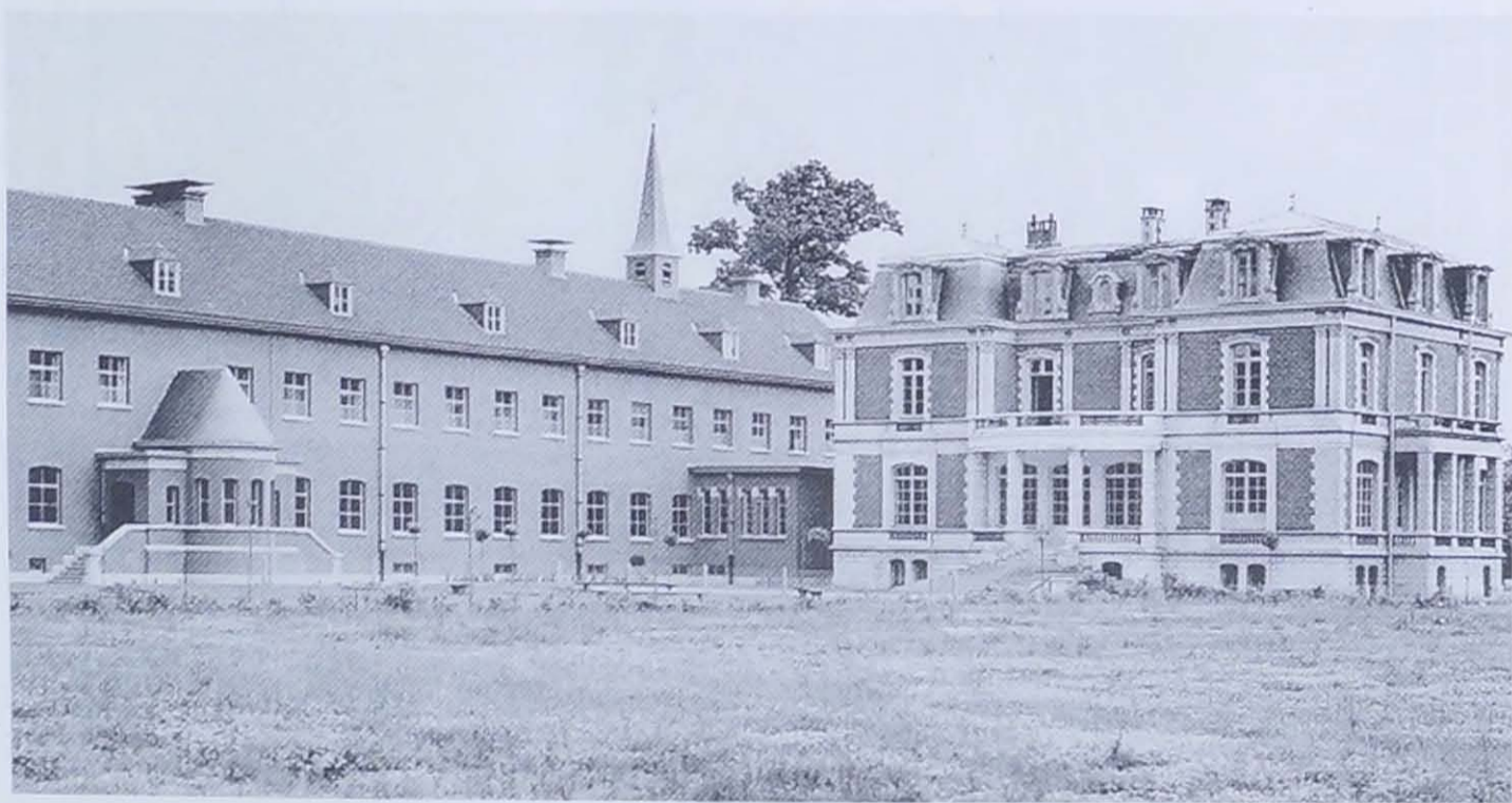
Zicht op het kasteel en de nieuwe gebouwen van het noviciaat van de Broeders van Liefde.
