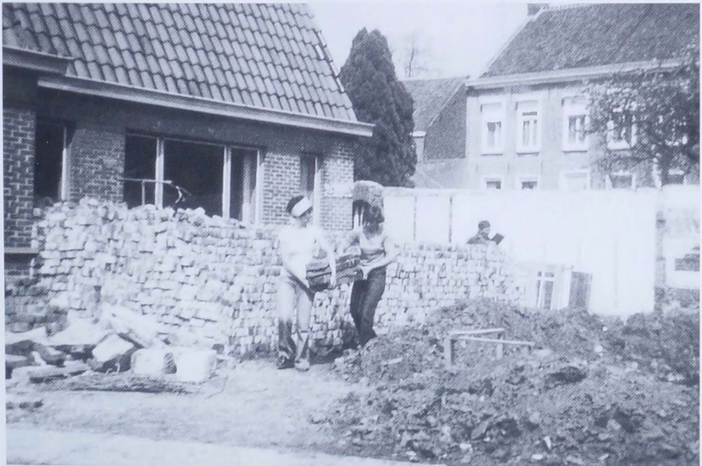
Lieve Seys en Gisèle Van De Moortele recupereren houten balken.
