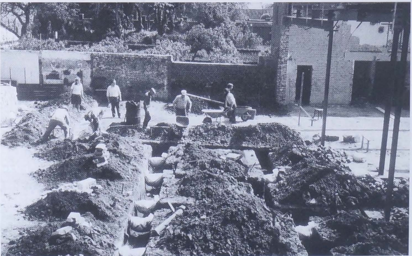
De nieuwe achterbouw krijgt stilaan vorm. De zware steunbalk ligt al op zijn plaats.
