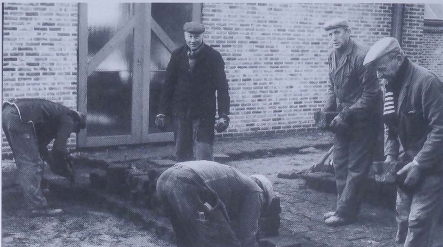
Van de firma Louwyck kwam belangrijke hulp. René Haesaert, Gustaaf De Clercq en Jules Wyckstandt brengen straatstenen aan.
