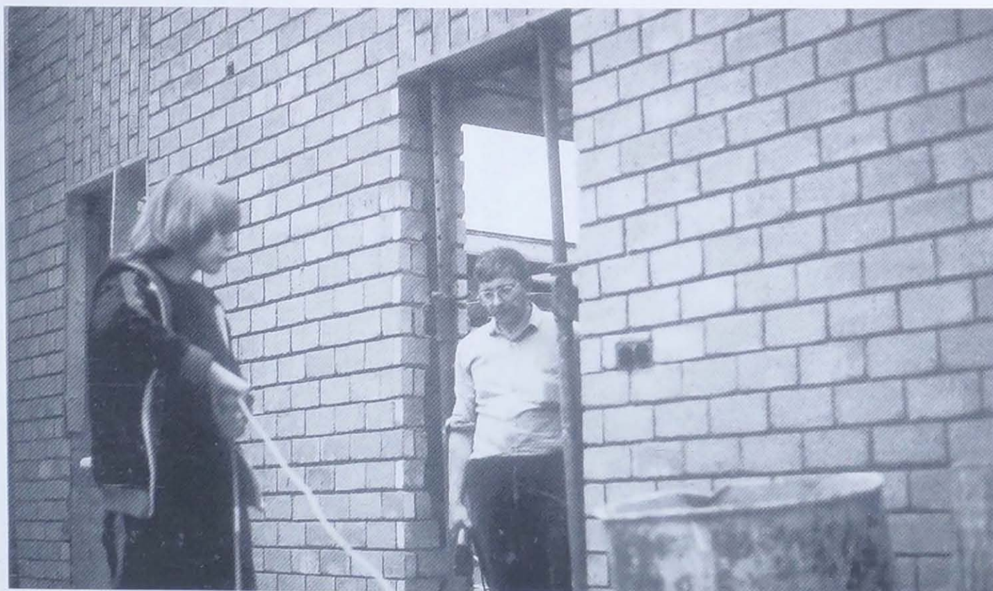
De elektriciteitskabels worden door de familie Versigghel gelegd.
