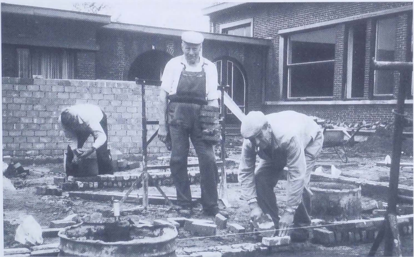
De KBG-ers trekken tijdens de week de binnenmuren op: Maurice De Smet, René Haesaert en Raymond Corthier.
