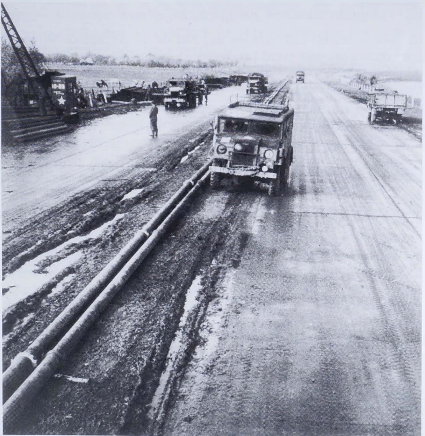
Aanleg van een pijpleiding tussen Aalter en Nevele.
