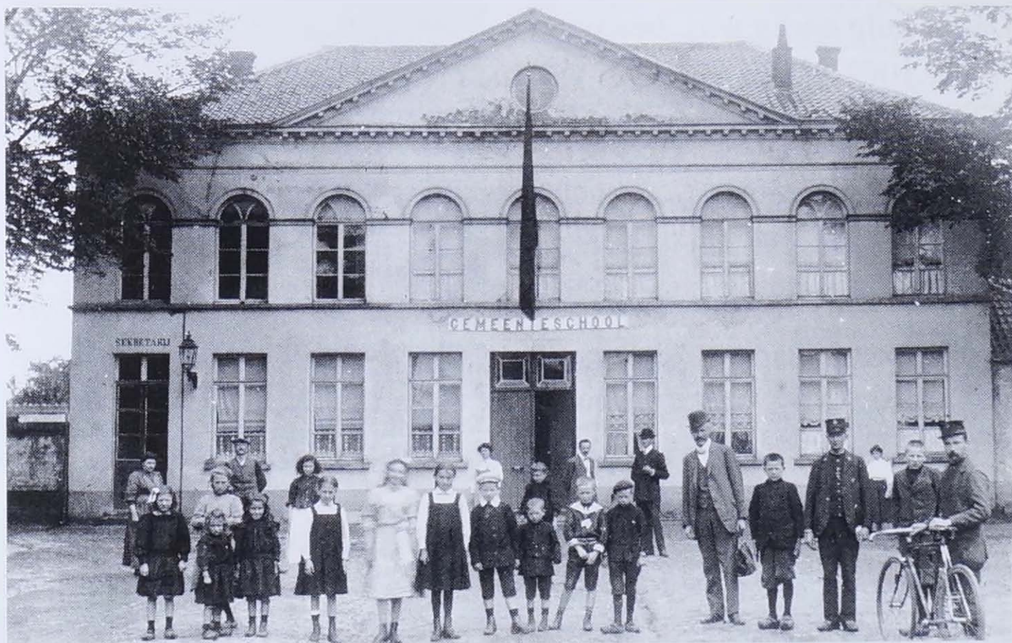
De gemeenteschool rond 1910. Het gebouw was grotendeels een school en woning voor de onderwijzer. Uiterst links de toegang tot het gemeentesecretariaat.
