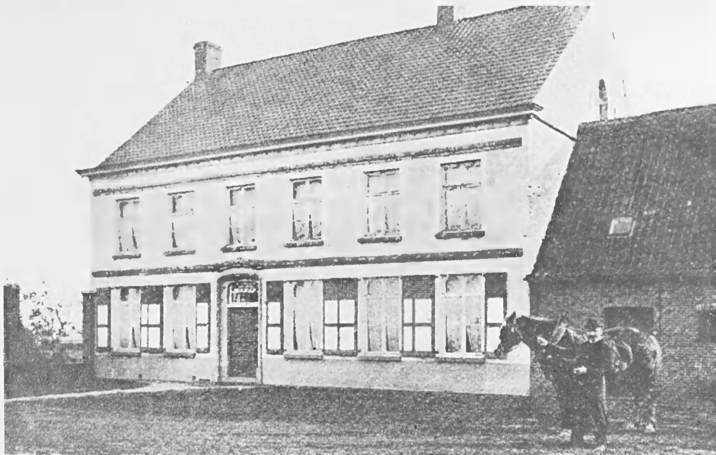
"De drie Posthoorns" op de zuidkant van de vaart, ten oosten van de nieuwe bruggen. Een oude posterij, in 1888 herbouwd en in 1928 gesloopt (nu villa Mevr. Em. Thienpont-Bockaert)
