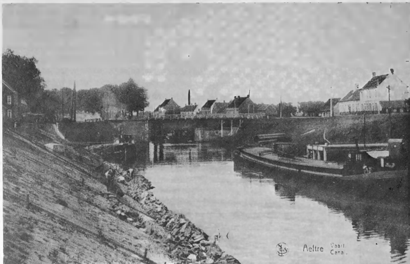
Noordzijde van de vaart - De tweede woning is "St.-Aernout", een herberg, vermeld in de lijst van de herbergen van 1779. Tussen deze woning en de volgende lag een weg die nu de "St.-Godelievestraat" heet. Op de andere hoek van de straat, de westkant dus, stond eertijds het "Roodhuis" waar in 1709 een herberg was.
