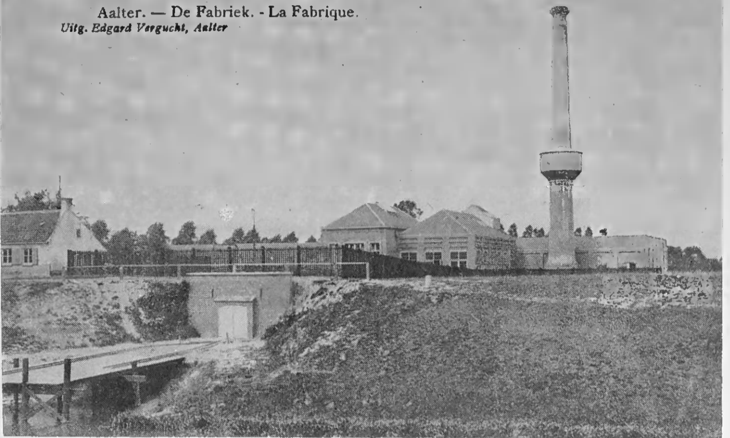
De Weverij M. Vanderhaeghen met aanlegsteiger.
