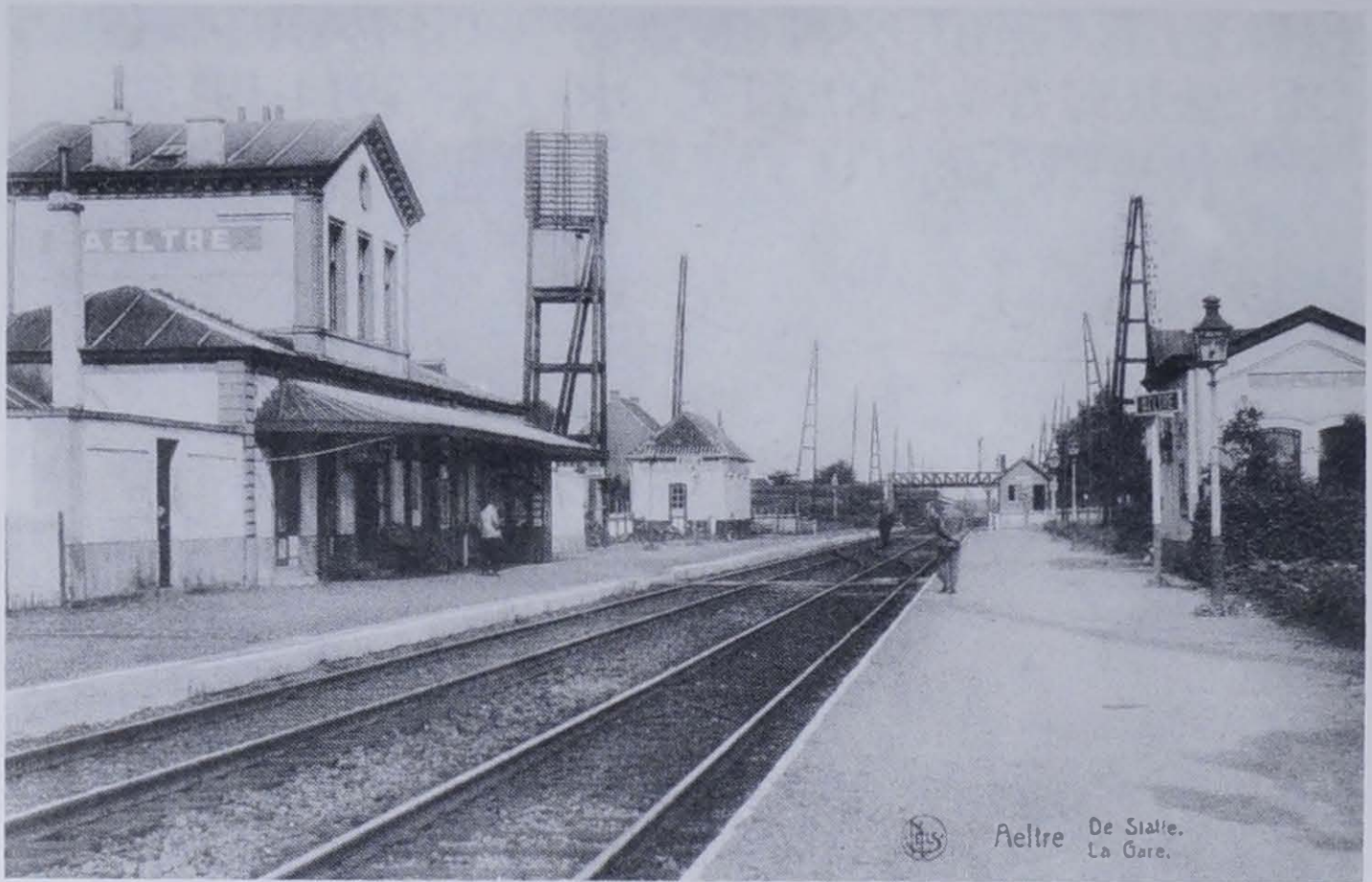
Het station van Aalter waar de Uhlanen de sporen dynamiteerden. In de verte de trambrug.
