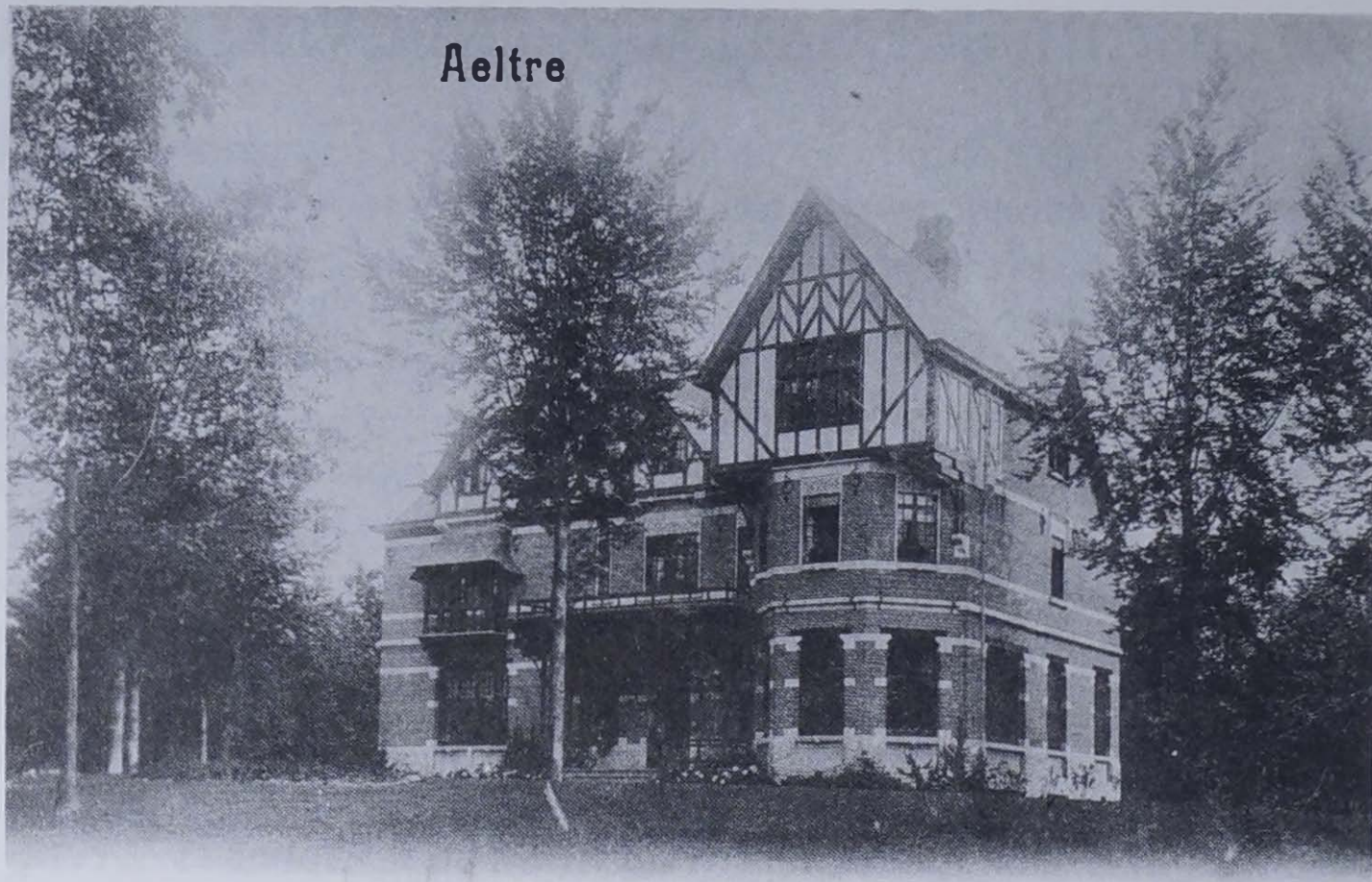
De villa aan de Kranepoel.
