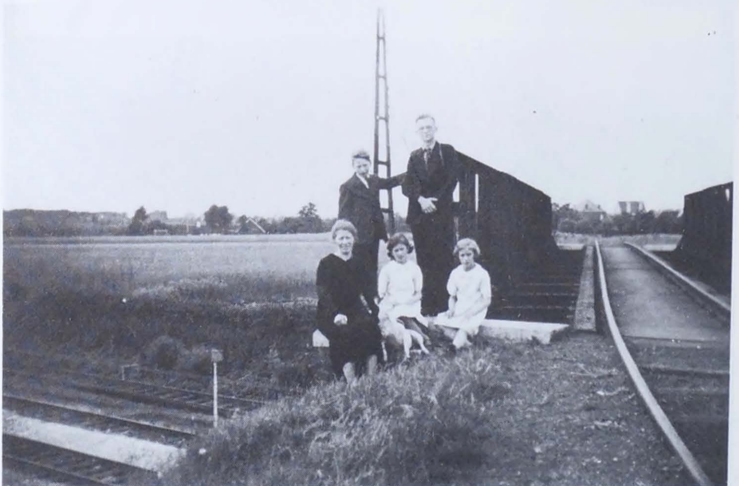
De brug over de spoorweg (trambuize) langs de buurtspoorweg Tielt-Eeklo. Deze brug werd rond 1948 verwijderd. (Foto : Gaby Bogaert.)
