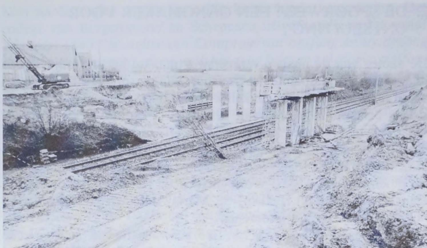
Spoorwegwerkzaamheden in de jaren '80. De aanleg van de nieuwe brug (voor 4 sporen) in de Weibroekdreef. (Foto : E. Van Eeghem, Aalter.)
