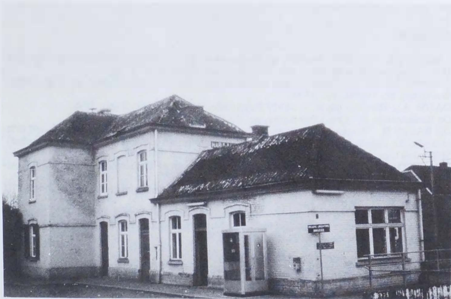
De zuidkant van het station na 1 februari 1964. (Foto : Julien Herman.)
